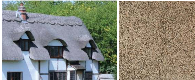
Figuur 114: Een rieten dak (links), houtwolcementplaat (rechts)
