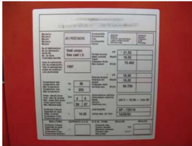
Figuur 108: Ketelkenplaat
