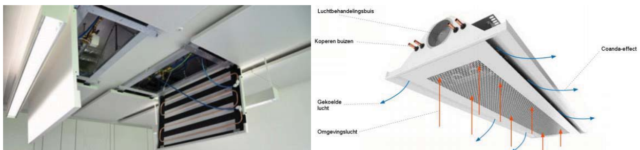
Figuur 66: Koelplafond (links) en koudebalk (rechts)
