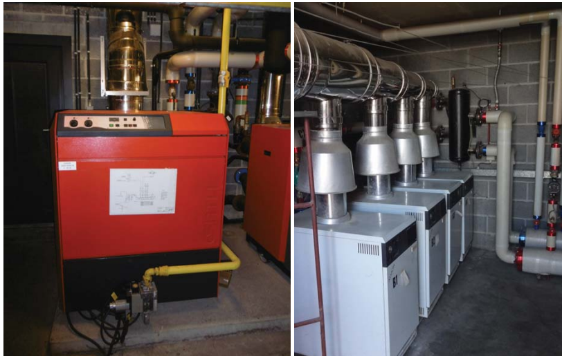
Figuur 29: Voorbeelden van ketels
