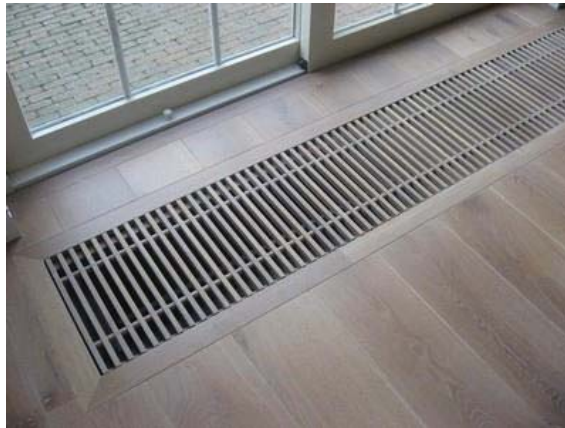
Figuur 56: Voorbeeld van een convector geplaatst in een convectorput
