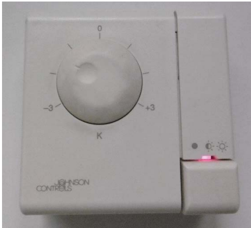
Figuur 61: Voorbeeld van een binnentemperatuursensor, met instelmogelijkheid "van -3°C tot +3°C", verbonden met een GBS
