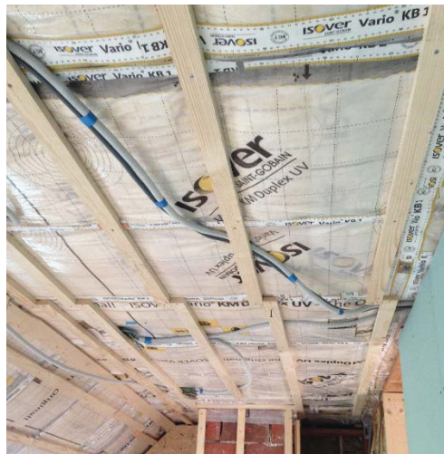
De binnenafwerking (vb. gipskartonplaten, houten plankjes) van een plafond kan door middel van vb. een houten lattenstructuur bevestigd zijn aan de plafondstructuur. Hierdoor ontstaat een leidingenspouw. Deze luchtlaag kan vastgesteld worden bij doorvoeropeningen, inbouwspots, ....
