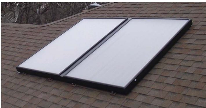
Figuur 34: Vlakke plaatcollectoren
