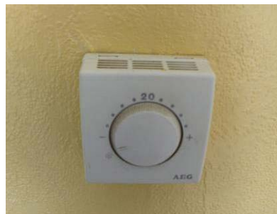
Figuur 63: Voorbeeld van een kamerthermostaat
