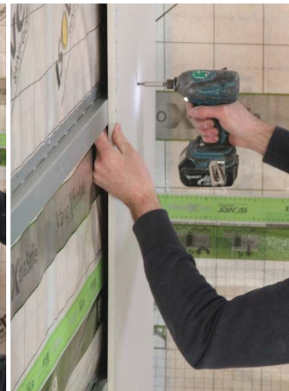
Figuur 57: Afwerkingsplaten op leidingenspouw
