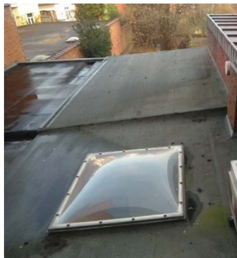
Figuur 10: voorbeeld van een plat dak (ondanks de aanwezigheid van een lichte helling)
