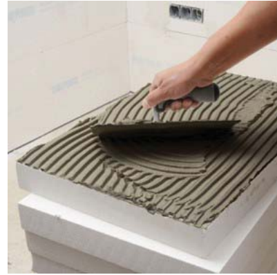
Figuur 54: Lijm op binnenisolatie
