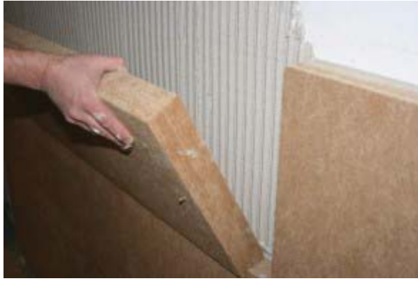
Figuur 53: Lijmen van binnenisolatie
