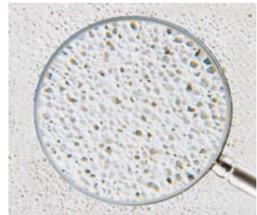
Figuur 69: Poreus oppervlak cellenbeton
