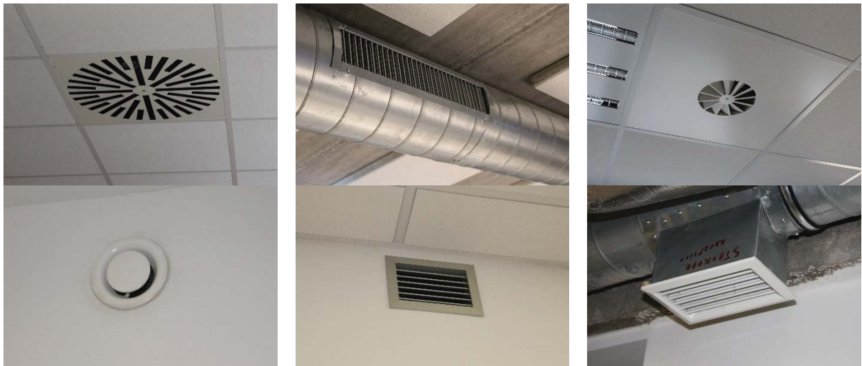
Figuur 48: voorbeelden van mechanische ventilatieopeningen
