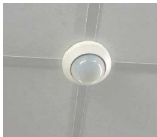
Figuur 87: Opbouwsensor (plafond)
