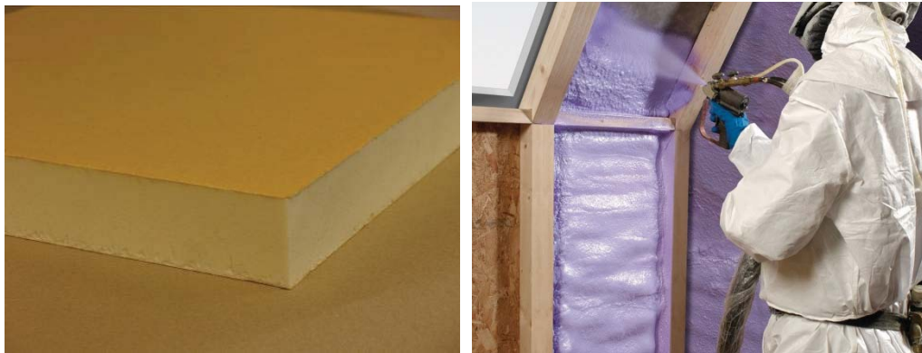
Figuur 109: PUR/PIR: platen (links) en ingespoten (rechts)
