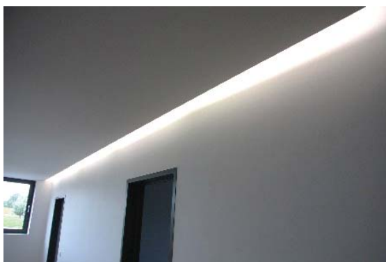
Figuur 243: Voorbeeld van indirecte verlichting in het plafond (verlichtingsgoot)
