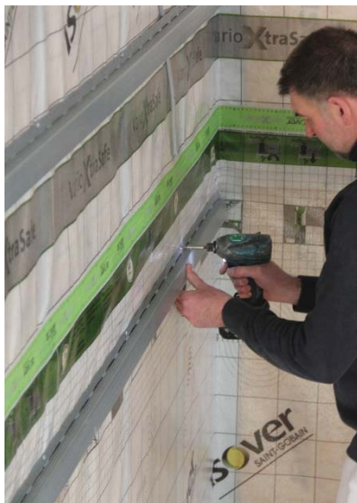
Figuur 55: Bevestiging van lattenstructuur
