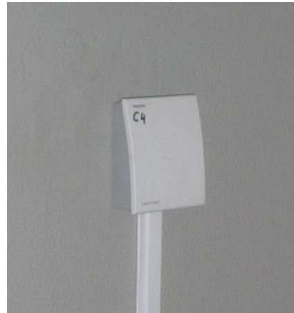
Figuur 62: Voorbeeld van een binnentemperatuursensor
