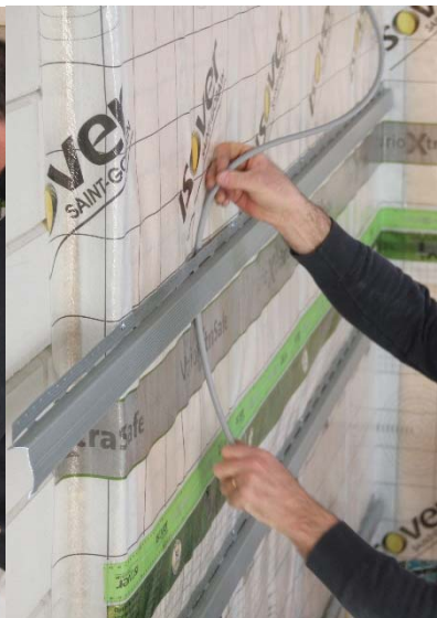
Figuur 56: Doorvoeren van leidingen door leidingenspouw
