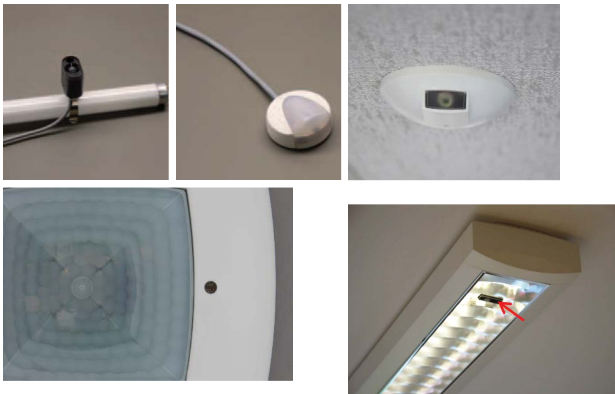
Figuur 258: Sensor voor verlichtingssterkte/daglichtsensoren: rechtstreeks op de lichtbron (boven links), voor opstelling aan het plafond in de ruimte (boven midden en rechts) en daglichtsensor geïntegreerd in sensor voor aanwezigheidsdetectie (onder links)
