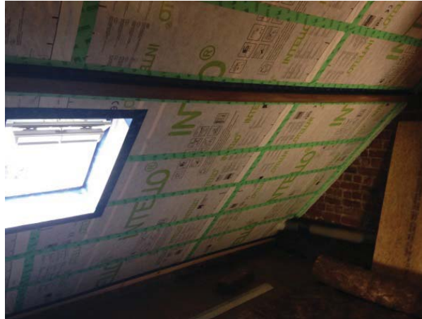
Figuur 71: Dampscherm bij een hellend dak
