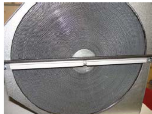
Figuur 52: schema en voorbeeld van een warmtewiel
