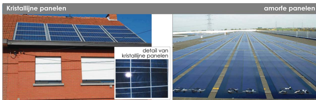
Figuur 240: Kristallijne panelen (links) en amorfe panelen (rechts)
