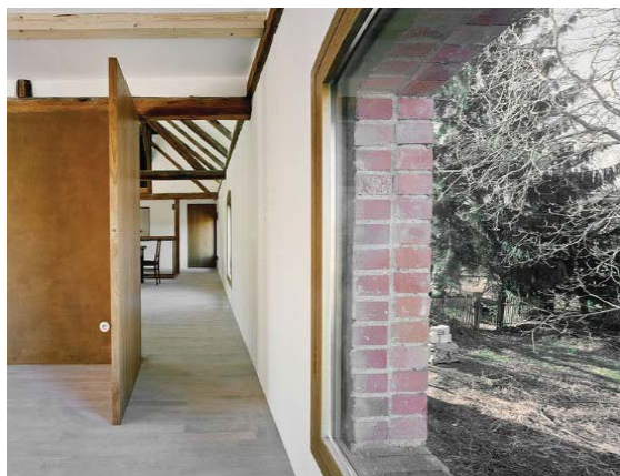
Figuur 50: Binnenisolatie afgewerkt met pleister
