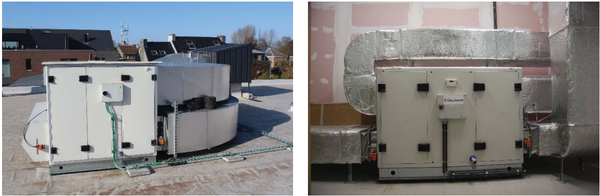
Figuur 45: voorbeelden van mechanische toevoer- en afvoerventilatorgroep
