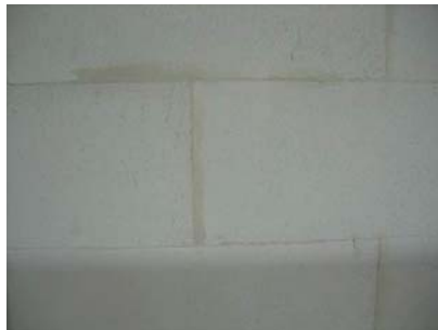
Figuur 68: Cellenbetonblokken van na de jaren '80
