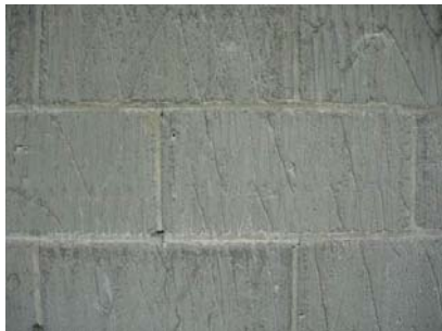
Figuur 67: Cellenbetonblokken van voor de jaren '80
