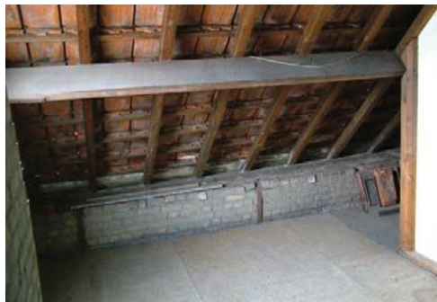
Figuur 95: Mogelijkheid om de samenstelling van de muur te bepalen vanuit de zolder
