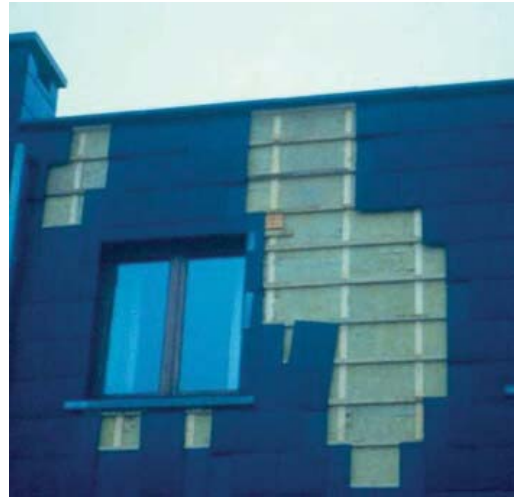
Figuur 62: Luchtlaag achter beplating
