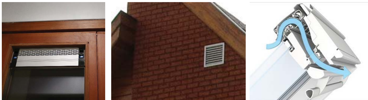
Figuur 221: Roosters op beglazing, in muur, in raamprofiel
