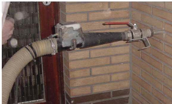
Figuur 100: Plaatsen van na-isolatie
