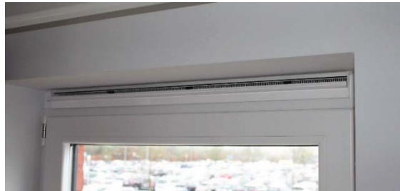
Figuur 47: Regelbare toevoeropening geïntegreerd in raamprofiel
