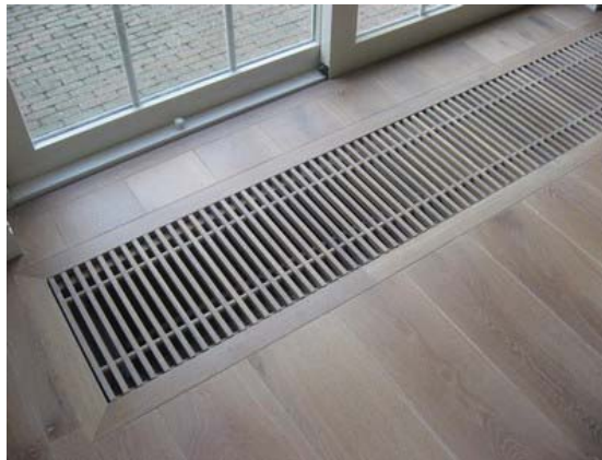
Figuur 162: Convector geplaatst in convectorput
