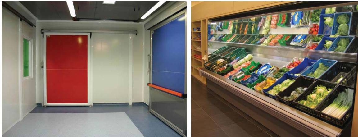
Figuur 173: Voorbeelden van proceskoeling: koelcel (links) en koeltoonbank (rechts)
