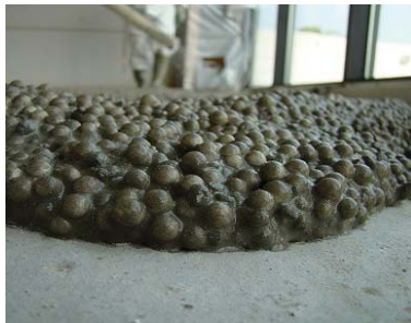
Figuur 72: Isolerende uitvullingslaag met EPS korrels
