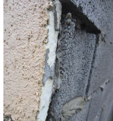
Figuur 60: Pleisterlaag (roze) op EPS (wit)
